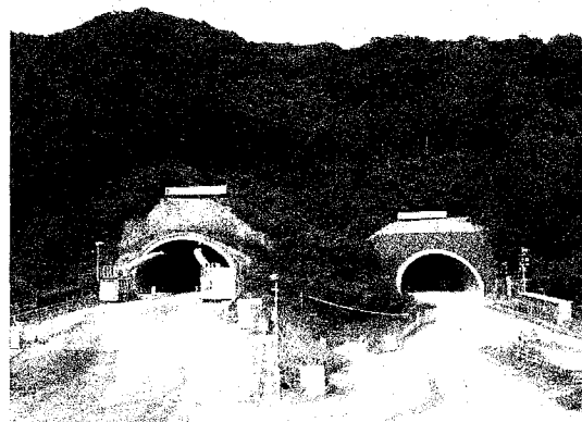
写真-1 金谷トンネル西側坑口
