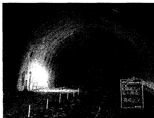
写真-1 測線展開および発破による起震状況
