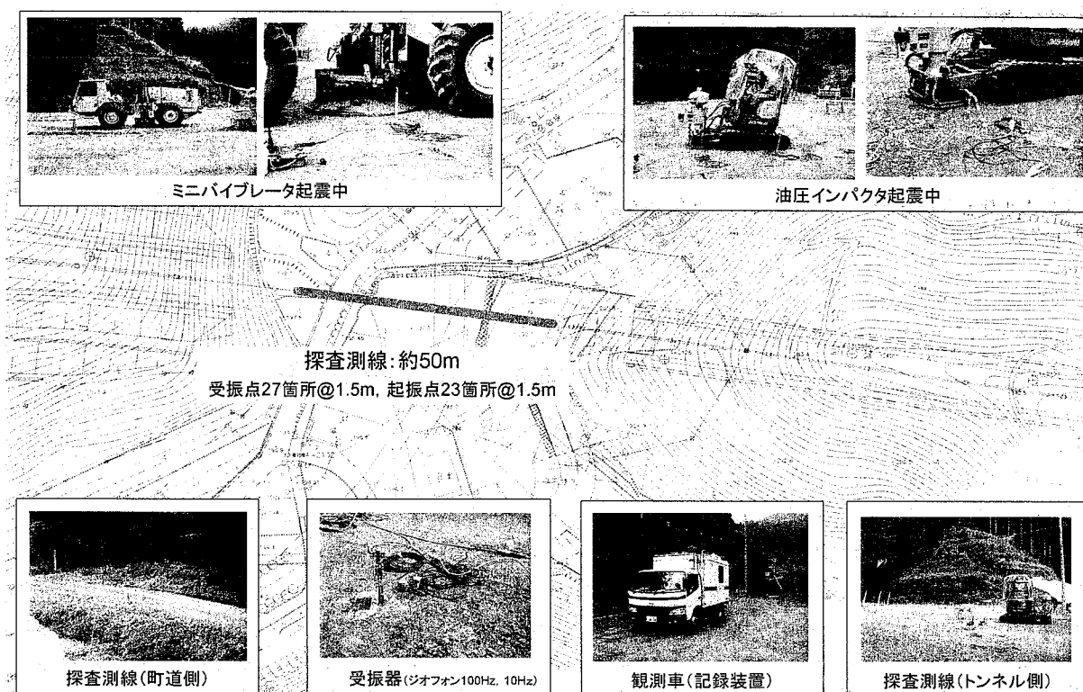
図-7 SSRT探査状況
