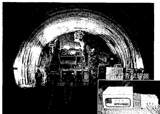
写真-1 トンネル施工状況
