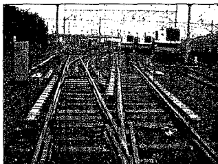
写真-4 分岐部分の軌道補強工事桁による補強
