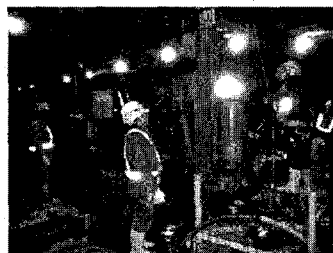
写真-12 坑内 SJM の施工状況
