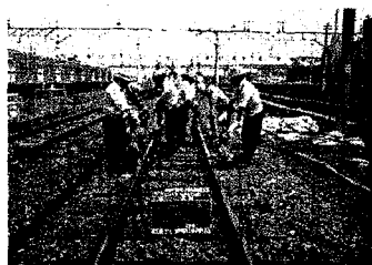
写真-5 軌道整備状況
