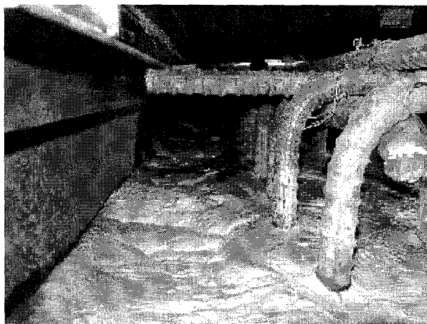
写真2 エレメント内コンクリート打設状況
