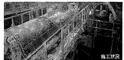
写真-1 パイプルーフ施工状況
