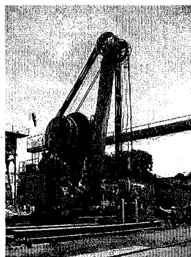
写真-4 施工状況
