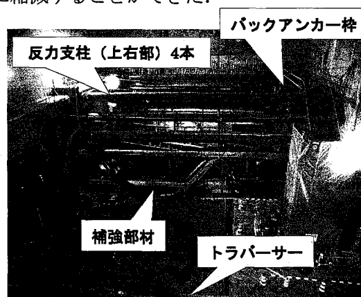
写真-2 復路の発進設備と地山貫入後の立坑状況
