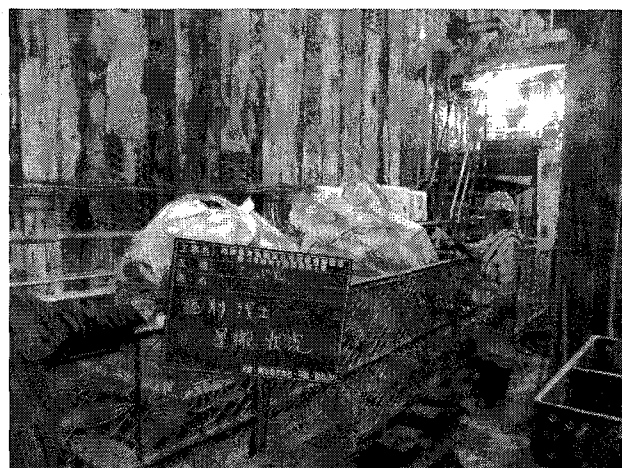
図-10 大型土のうによる残土集積
