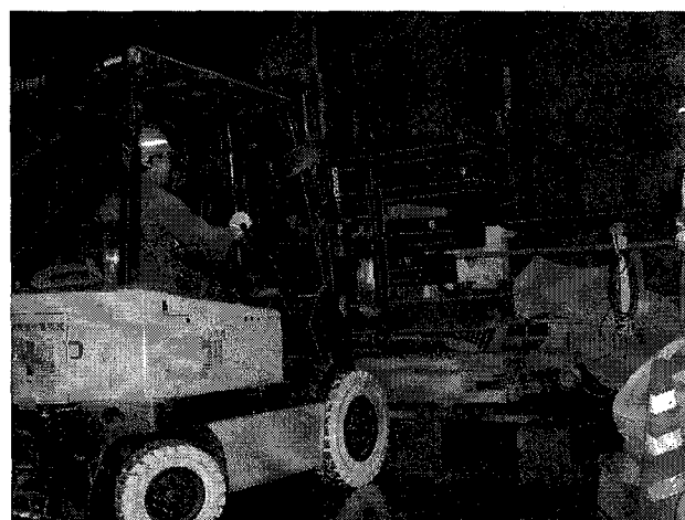
図-11 資材運搬用フォークリフト
