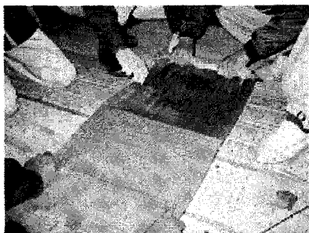
写真-1 高密度ポリエチレン繊維一体型光硬化樹脂接着シート
