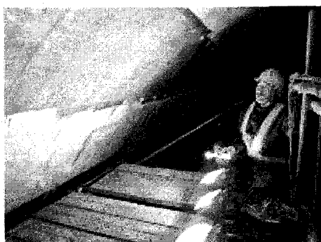
写真-2 光照射によるシートの光硬化
