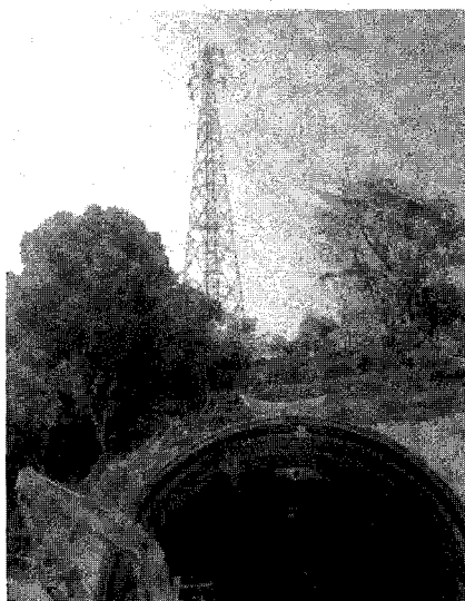
図-2 トンネル坑口と送電鉄塔
