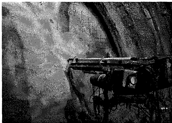
写真-1 GFRP チューブ打設状況
