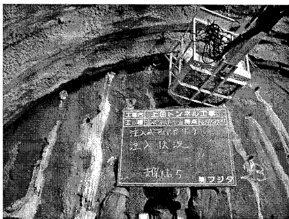
写真-5 注入式フォアポーリングの施工状況
