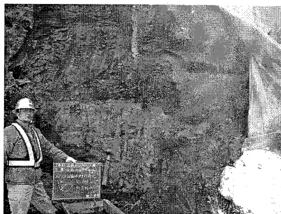
写真-3 全方位高圧噴射工法の改良体の施工出来形 [上半右側脚部:2列施工]
