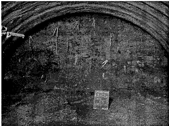
写真-7 切羽写真 [No.128+12 : 風化ひん岩]
