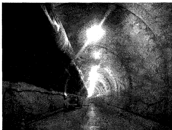
写真-1 NATMによるトンネル
