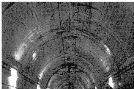
写真-2 妙見トンネル被害状況
