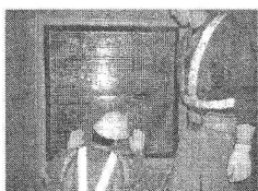
(d) 光硬化型シートの貼付
