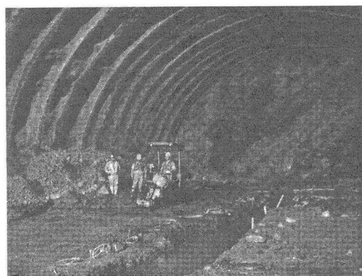
図-7 油圧インパクト起振状況
