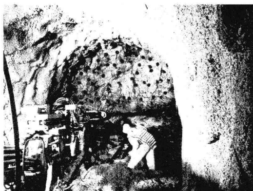
写真－2 B避難連絡坑における自由面形成状況
