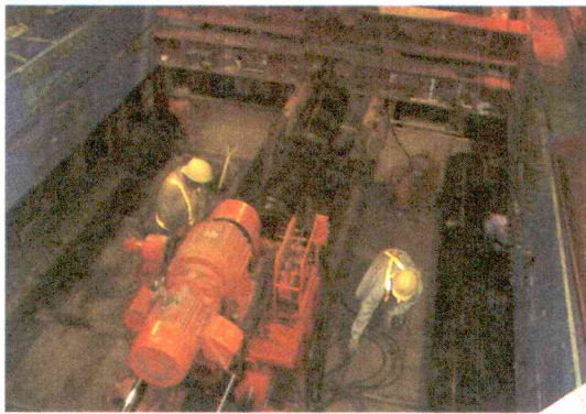
写真-5 パイプルーフ施工状況
