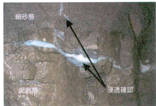
写真-4 薬液注入浸透確認
