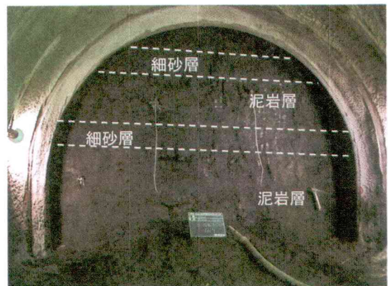
写真-3 切羽状況(湧水なし)
