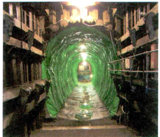
写真-6 パイプルーフ施工及び掘削完了
