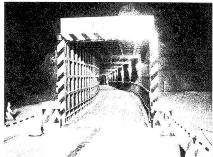
写真-6 プロテクター設置完了（起点側）
