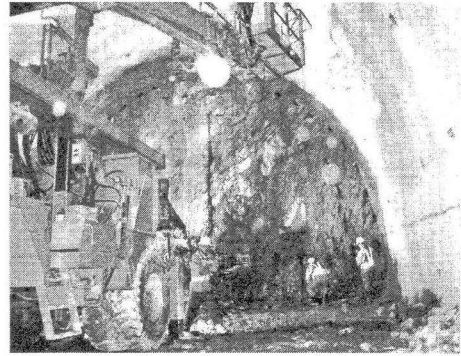
写真-2 SD・EDD 発破におけるスロット削孔施工状況
