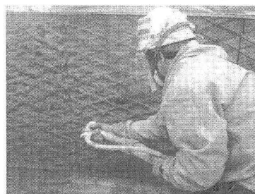
写真-2 ECCの吹付け状況
