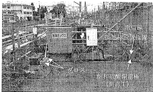
(a) レール対地電圧測定状況
