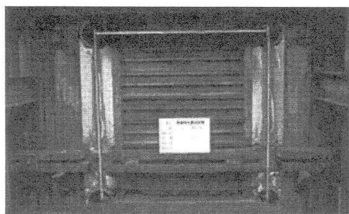
写真-3 鋼板挿入完了状況
