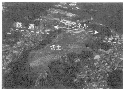
写真-1 トンネル上部の切土工事の例
