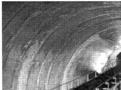
図-16 脱型後の一次覆工コンクリートの状況
