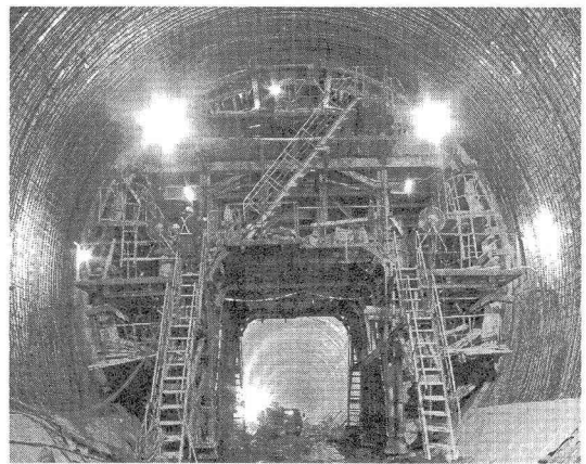
写真—5 アーチ覆工施工状況
