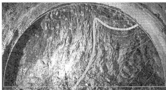
写真—2 切羽面波形地層状況
