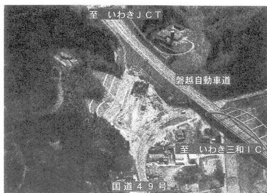
写真-2 トンネル終点側坑口部付近
