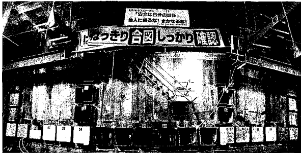
写真-4 推進完了状況
