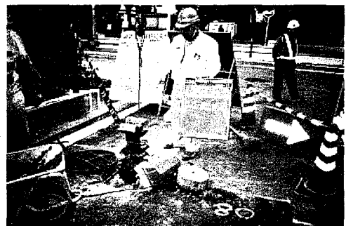
写真-5 掘進機搬出状況
