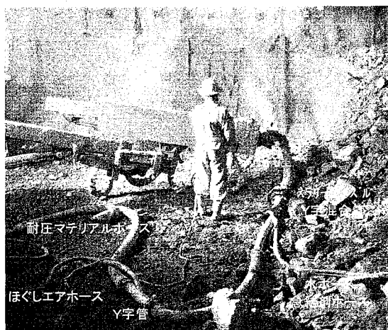
写真－３ スラリー化方式吹付け状況
