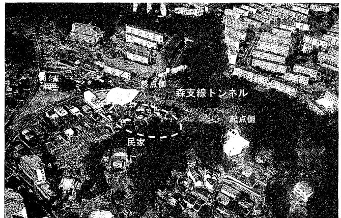
写真－1 施工箇所周辺
