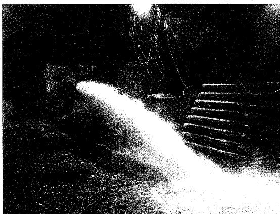
写真-1 長尺ボーリング湧水状況
