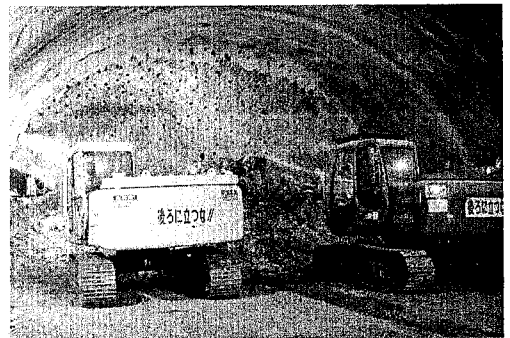
写真-2 割岩工法施工状況
