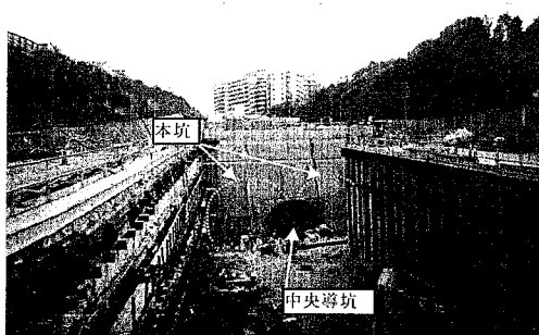
写真-3 北側坑口状況
