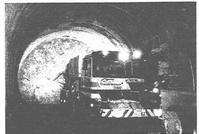
写真-3 吹付け施工状況
