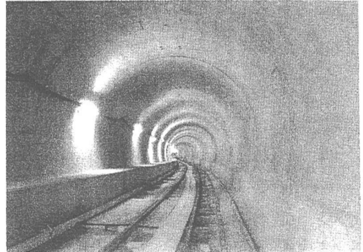
写真-3 覆工完了全景
