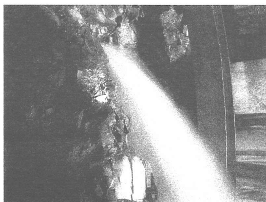
写真-3 切羽・湧水状況
