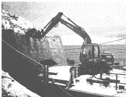
写真-2 起点側坑口巻出し部撤去状況
