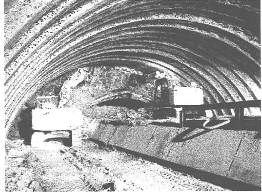
写真-1 上半掘削の状況
