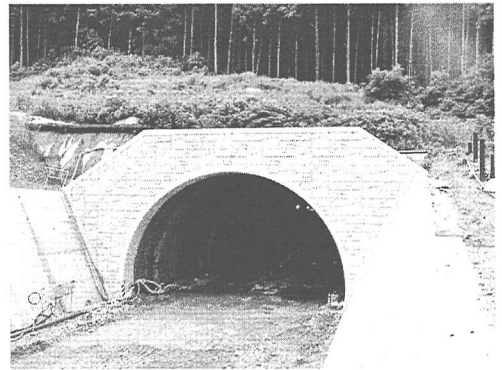
写真-4 坑口施工完了状況
