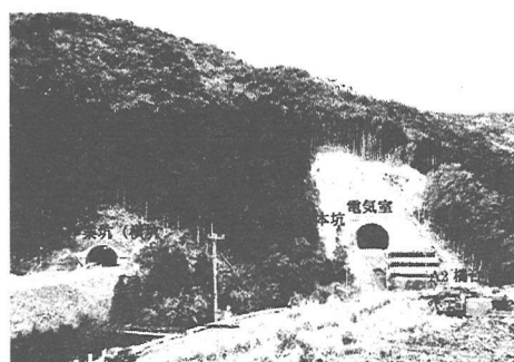
写真-6 始点側坑口部掘削完了状況
