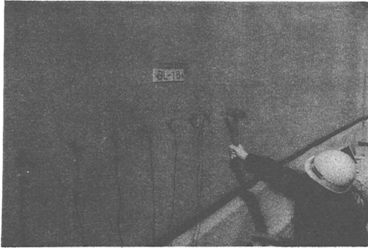
写真-2 探査作業の状況
