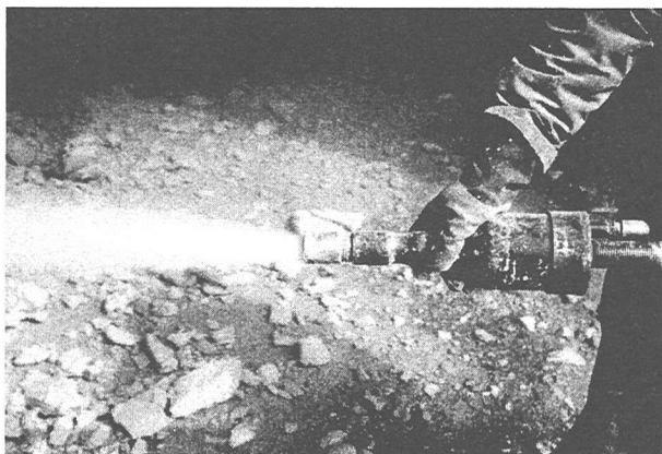
写真-1 スラリー化の状況
