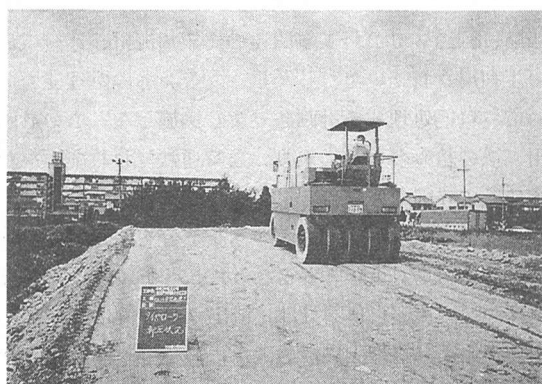
写真-6 ローラーによる転圧
