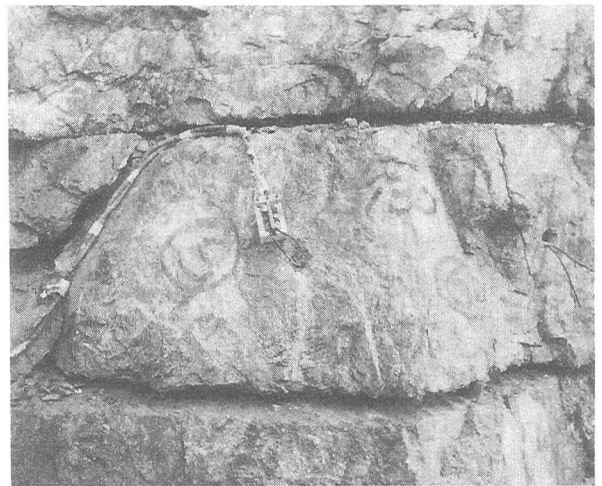
写真－2 破碎前の状況
