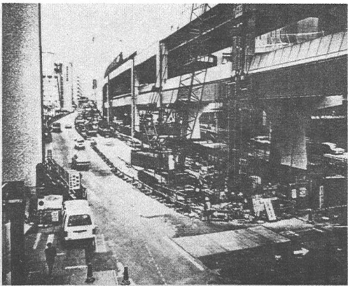
写真－1 連続地中壁施工状況
