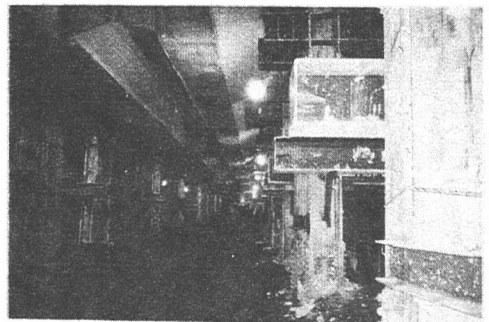
写真-5 地下3階掘削状況全景
