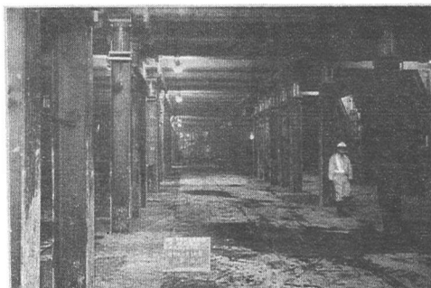
写真-3 路下掘削完了全景
