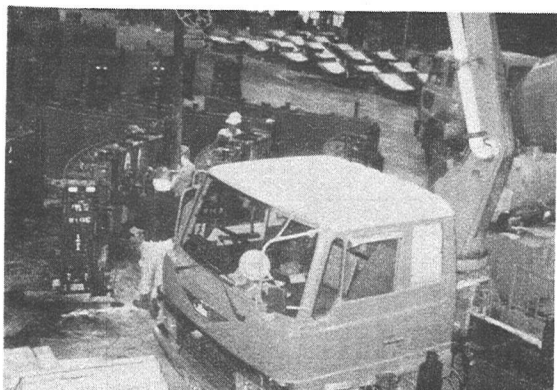
写真－３ コンクリート充填状況
