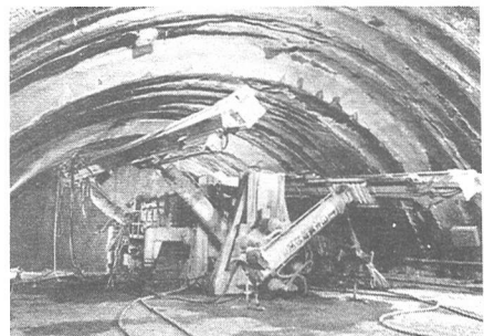
写真-1 トレビチューブ専用削孔機
